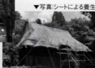
▼写真:シートによる養生
