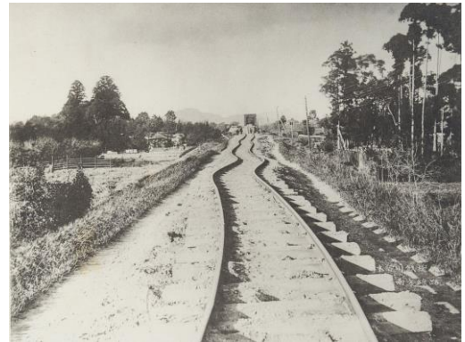
濃尾地震により湾曲した線路
