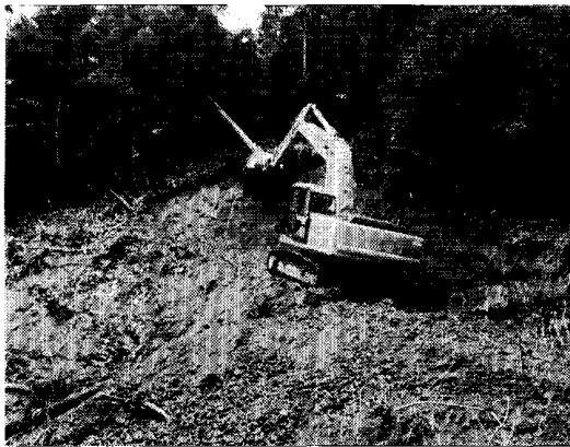
▲掘削作業の状況
