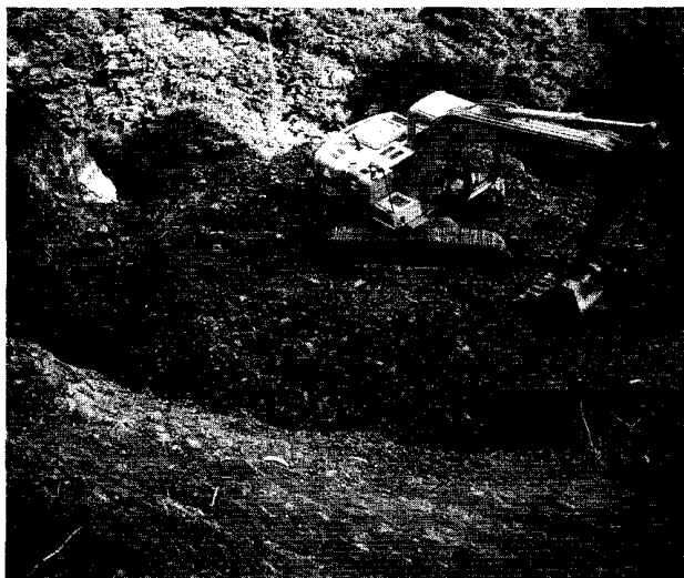
(掘削作業の様子)
