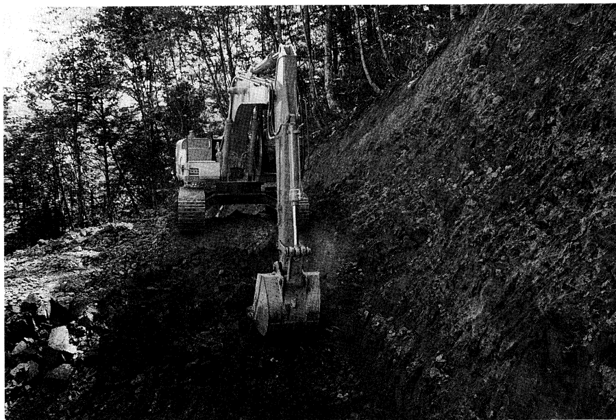
図版3 露頭掘削の様子
